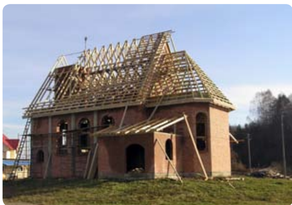
Budowa kościoła w Zasławiu
