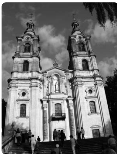
Fasada kościoła w Piekoszowie
